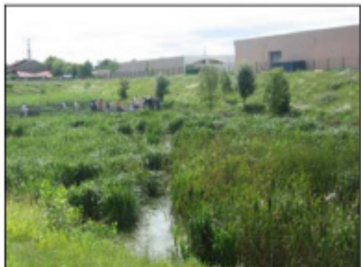
Estanques de Retención
