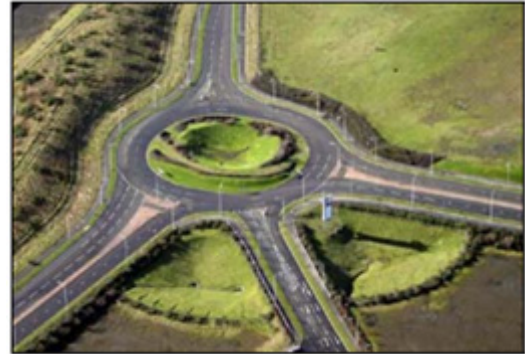
Depósitos de Detención
