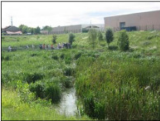
Depósitos de Infiltración
